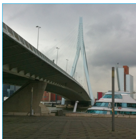
Door luminar ingesteld
